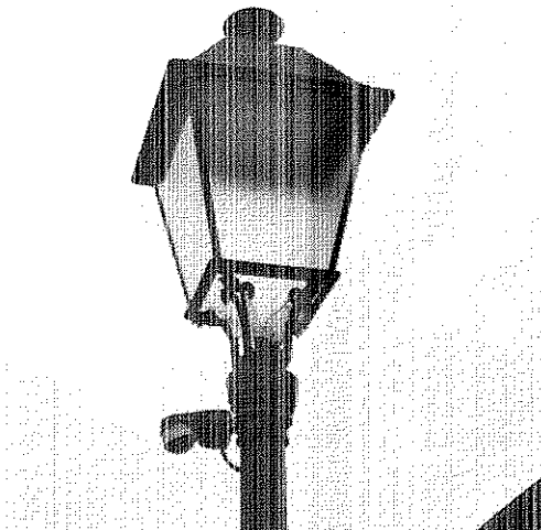
Fotografía N° 5: Luminaria Villa y sensor de presencia
