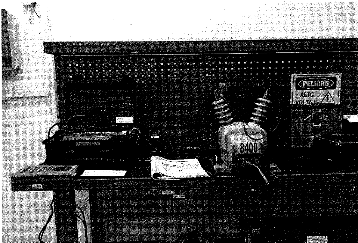
Imagen 6 Calibración de un Transformador de Potencial.
