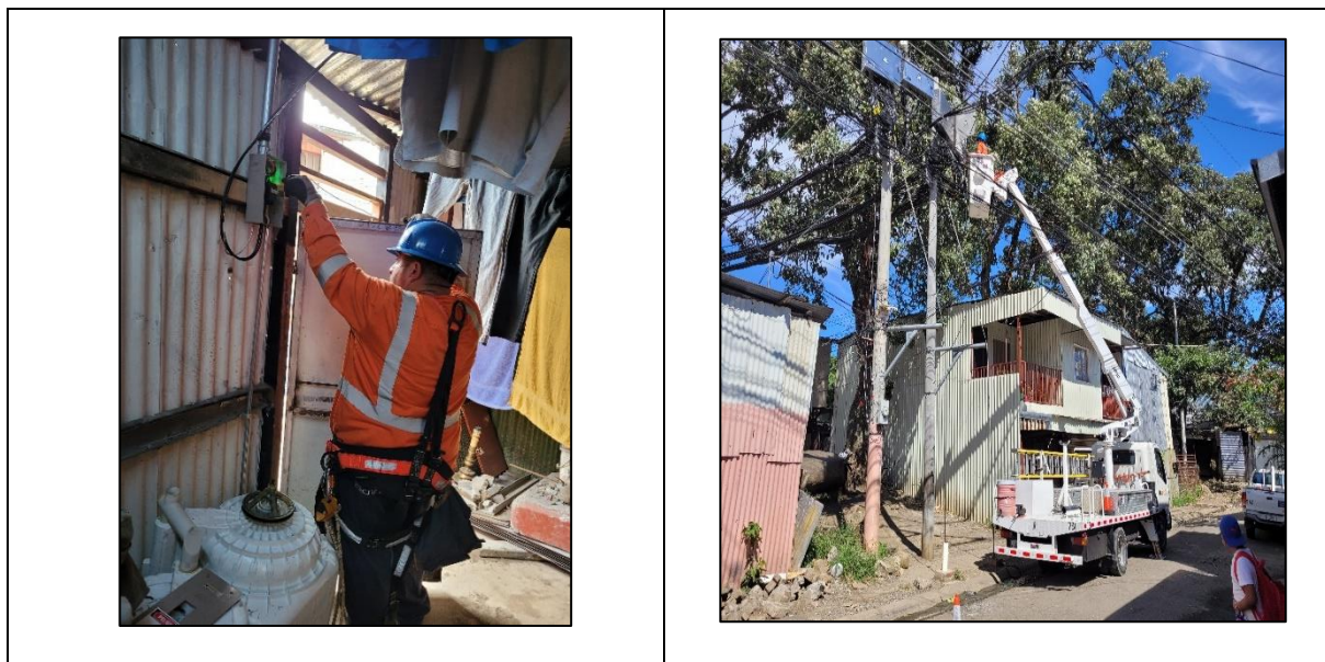
Figura 5 Trabajos técnicos, Comunidad de Tejarillos Unidad Sucursal Escazú
