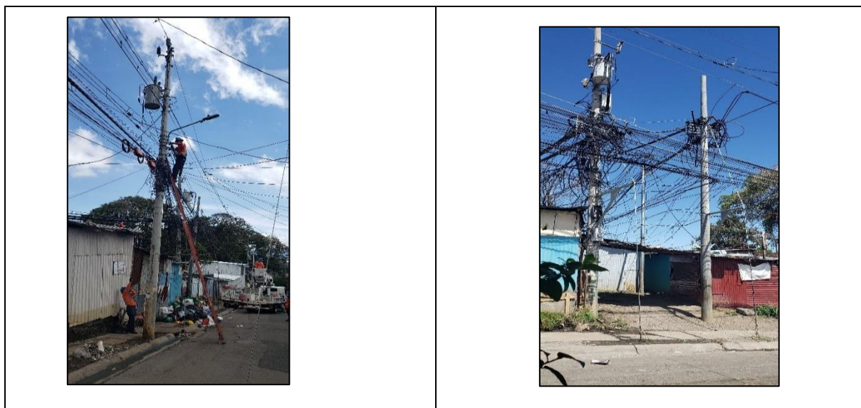
Figura # 6 Trabajos técnicos, Comunidad de Tejarillos Unidad Sucursal Escazú
