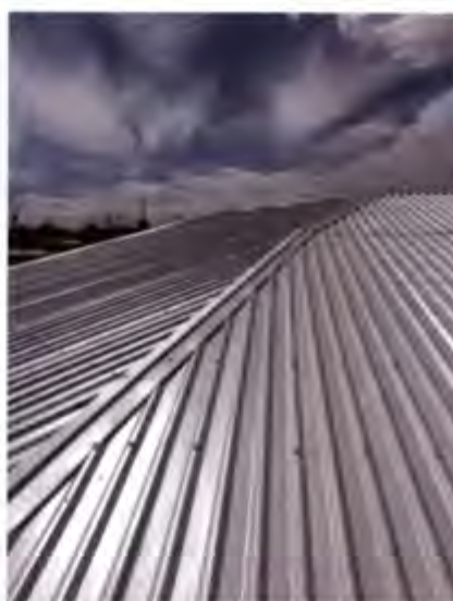
Laboratorio de Transformadores
