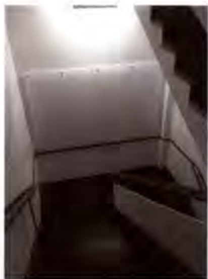
Núcleo de escaleras, Edif. Cincuentenario
