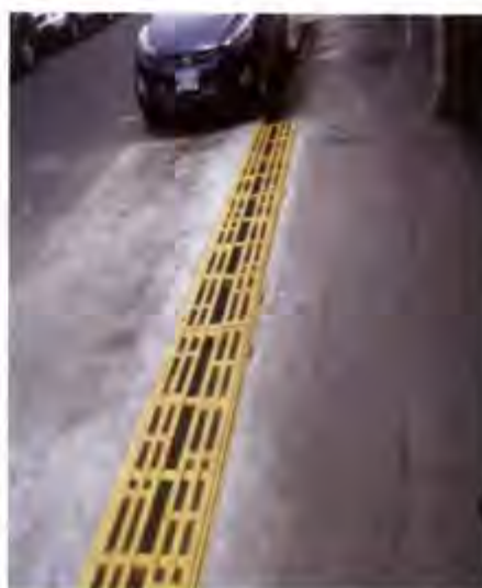
Acceso principal, parqueo Calle 21
