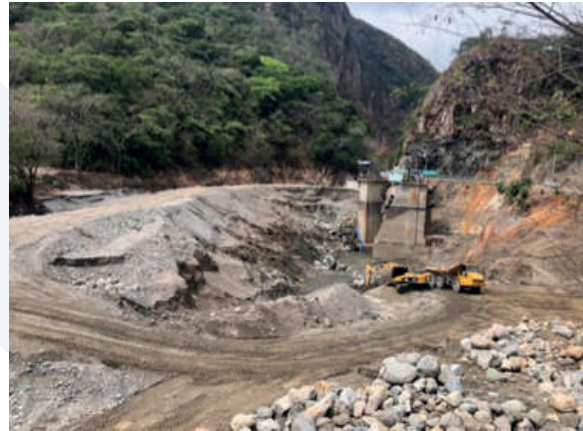
Imagen N° 1: Labores de retiro de sedimento de Toma planta El Encanto.
