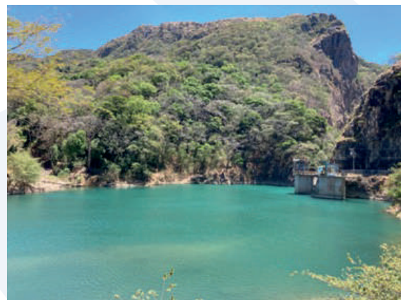
Imagen N° 2: Estado actual Toma planta El Encanto.
